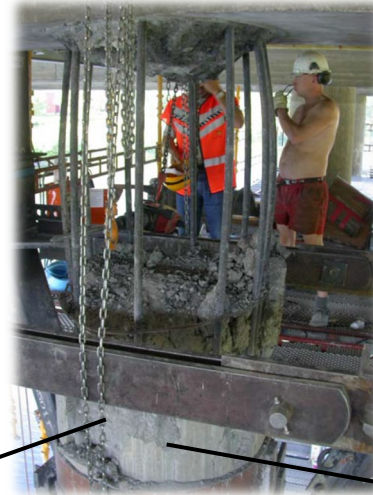
Skiftet ut øvre ca. 1,5 m av to søylerader
