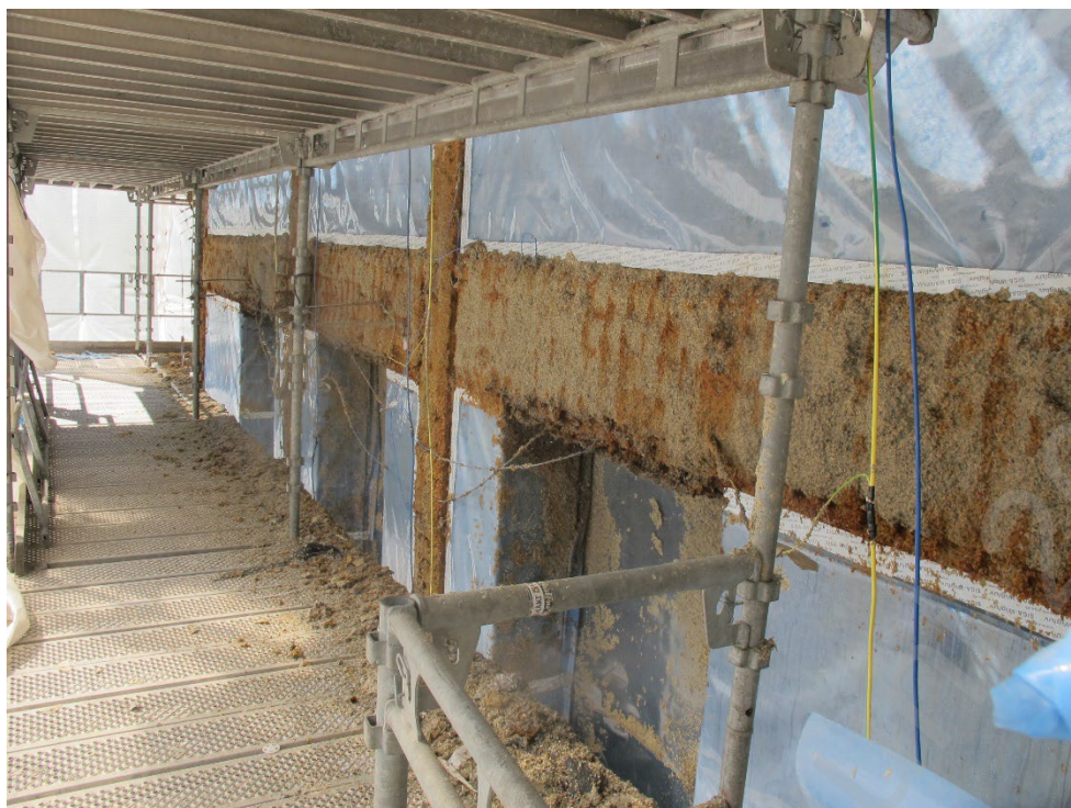
Figur 1.2 Kulturminne – fasaderehabilitering med elektrokjemisk realkalisering (Foto: Stærk & Co as)
