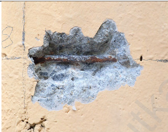
Figur 5.9 Armeringskorrosjon pga. karbonatisering. (Foto: Stærk & Co as)
