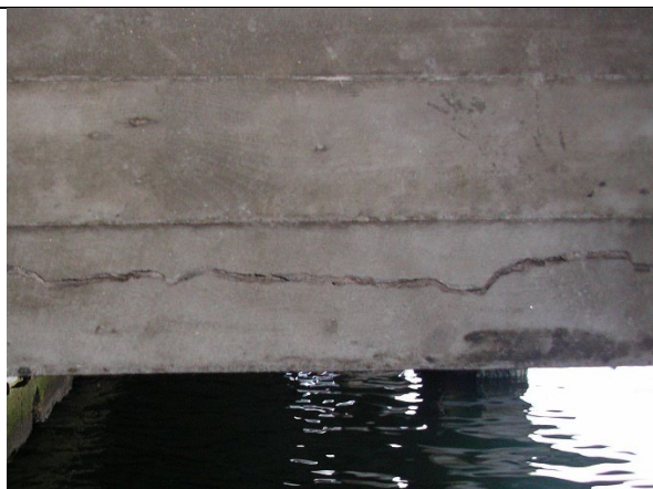
Figur 5.1 Riss pga. rustsprengning. (Foto: Stærk & Co as)
