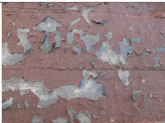
Figur 5.24 Malingsavflassing. (Foto: Stærk & Co as)
