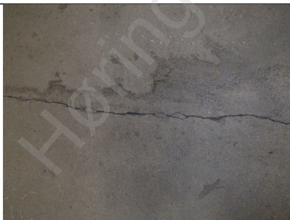
Figur 5.5 Svinnsprekk. (Foto: Stærk & Co as)
