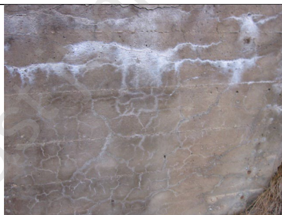
Figur 5.2 Riss pga. alkaliereaksjoner. (Foto: Stærk & Co as)
