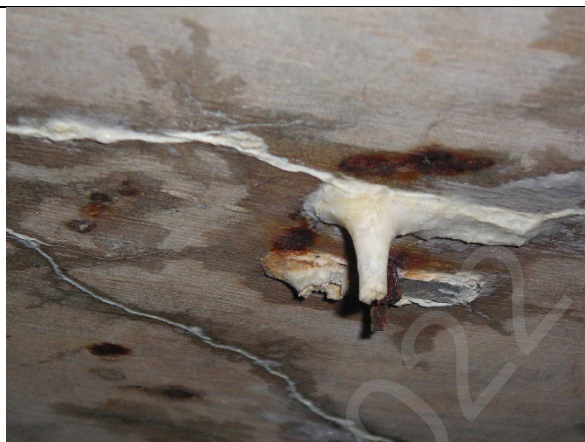
Figur 5.14 Rustutslag samt riss med kalkutfelling. (Foto: Stærk & Co as)
