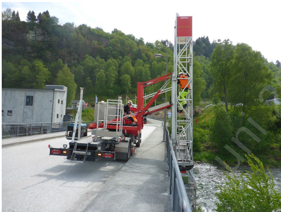
Figur 3.1 Inspeksjon av bru med brulift (Foto: Norconsult AS)
