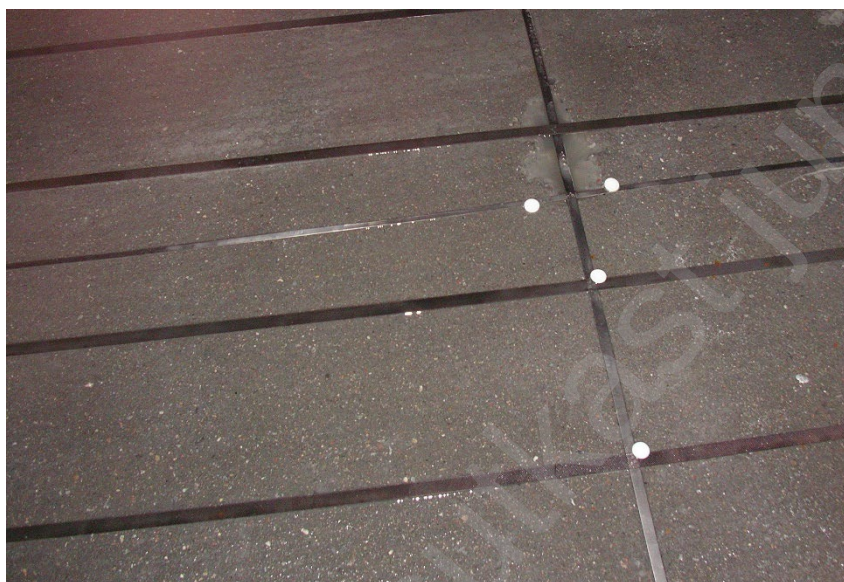
Figur 11.3 Katodisk beskyttelse parkeringsdekke med anodebånd. (Foto: Stærk & Co as)
