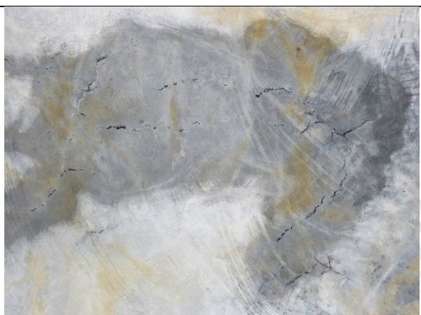
Figur 5.1 Riss pga. rustsprengning. (Foto: Stærk & Co as)
