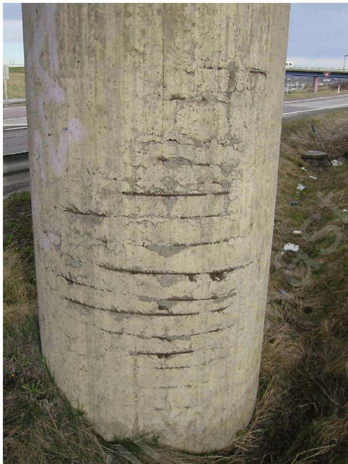
Figur 2.1 Betongkonstruksjon med behov for tilstandsanalyse (Foto: Norconsult AS)
