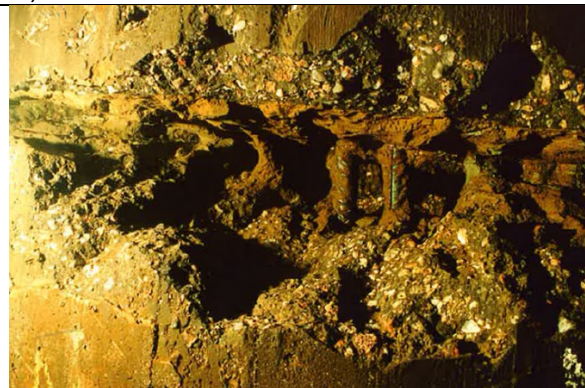
Figur 5.10 Armeringskorrosjon pga. klorider. (Foto: Stærk & Co as)
