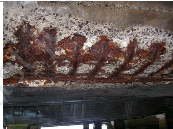
Figur 5.10 Armeringskorrosjon pga. klorider. (Foto: Stærk & Co as)
