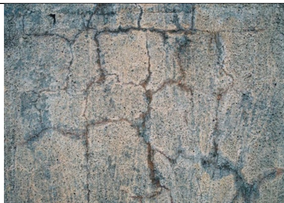
Figur 5.2 Riss pga. alkaliereaksjoner. (Foto: Stærk & Co as)
