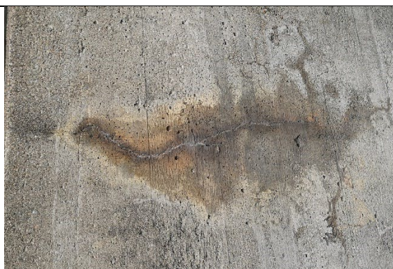
Figur 5.13 Utluting. (Foto: Stærk & Co as)
