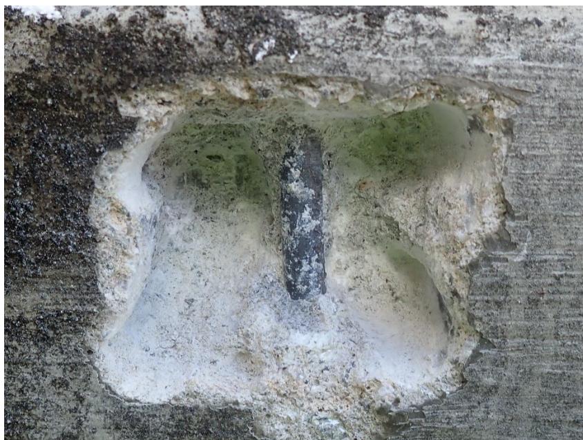
Figur 7.16 Opphugging for kartlegging av korrosjonstilstand på armering i karbonatisert betong. (Foto: Stærk & Co as)
