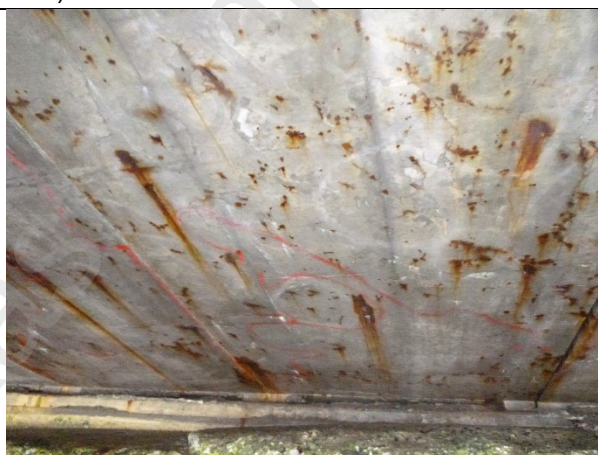
Figur 5.14 Rustutslag samt riss med kalkutfelling. (Foto: Stærk & Co as)
