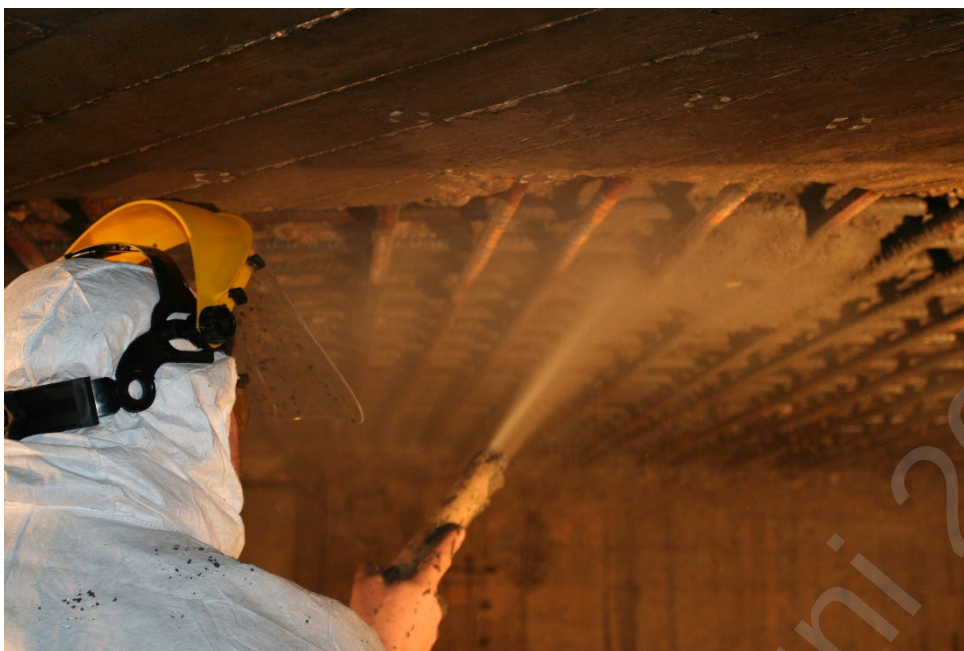
Figur 11.2 Reparasjon med sprøytemørtel. (Foto: Norconsult AS)
