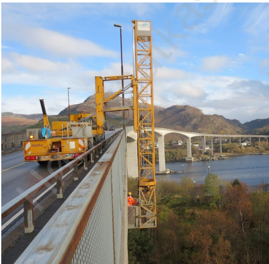
Figur 4.4 Bruk av underbrolift (Foto: Norconsult AS)
