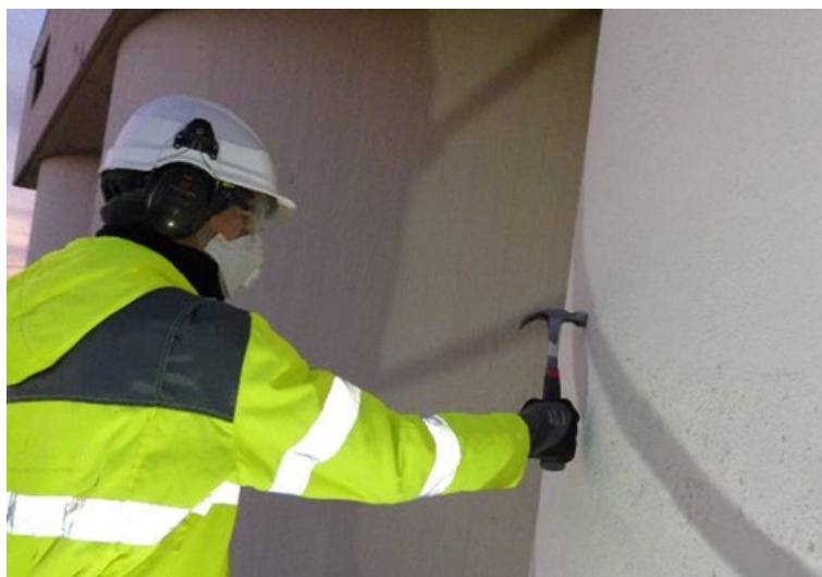
Figur 7.1 Bomkontroll med hammer. (Foto: Norconsult AS)
