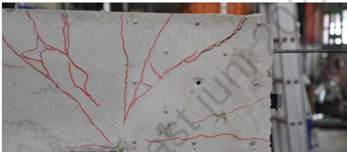
Figur I-4: DEMEC montert på et hjørne med sprekk.
